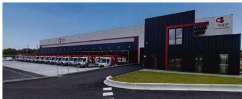
Plus grand des 15 sites logistiques d'Ouest Boissons, le nouvel entrepôt d'Auray gagne 700 m 2 de stockage, 3 mètres de hauteur sous plafond, 1000 emplacements picking et 300 m 2 de bureaux.
