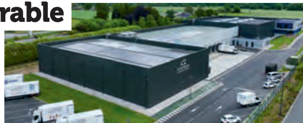
Dans son nouvel entrepôt, le distributeur normand a fait poser 2 000 m 2 de panneaux photovoltaïques pour assurer jusqu'à 37 % de ses besoins en électricité.
