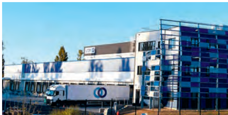
La BU RHD de Stef a notamment installé une centrale de cellules photovoltaïques sur son site de Miramas (p. 36).
